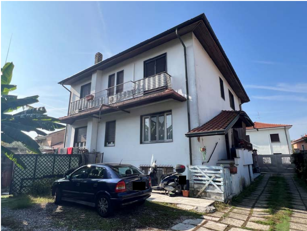
Fronte est su cortile comune
