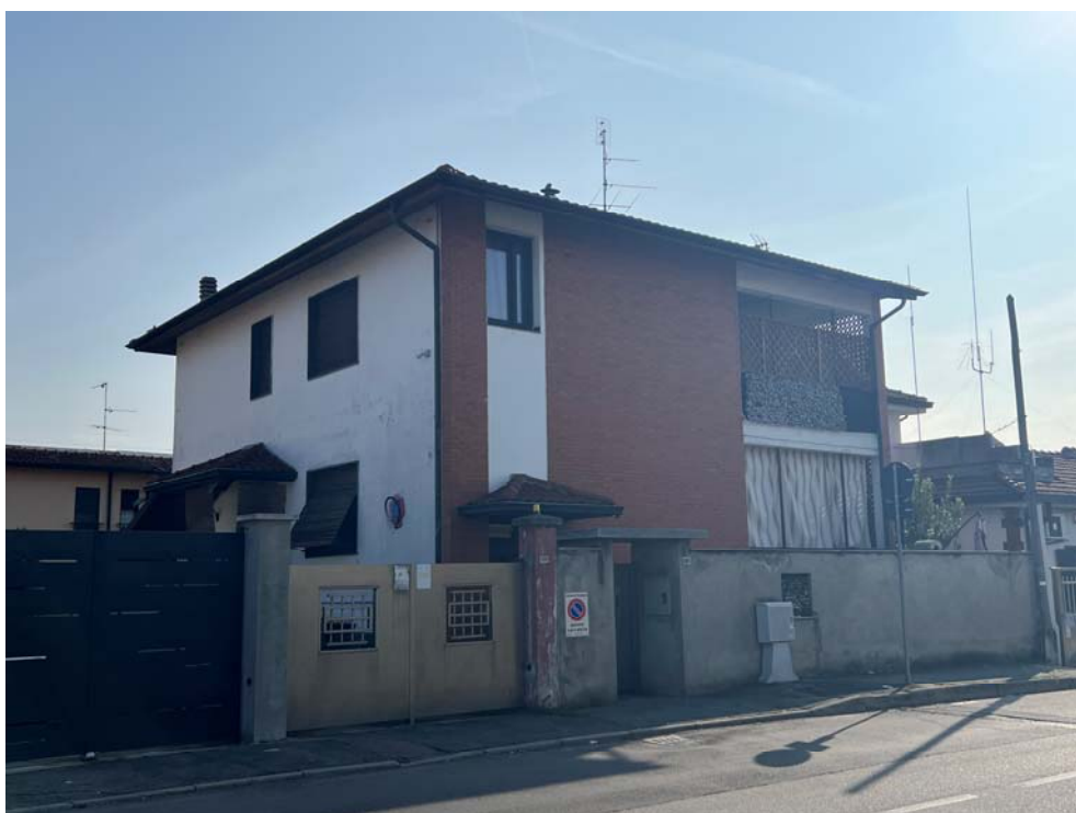
Fronte su strada e fronte nord
