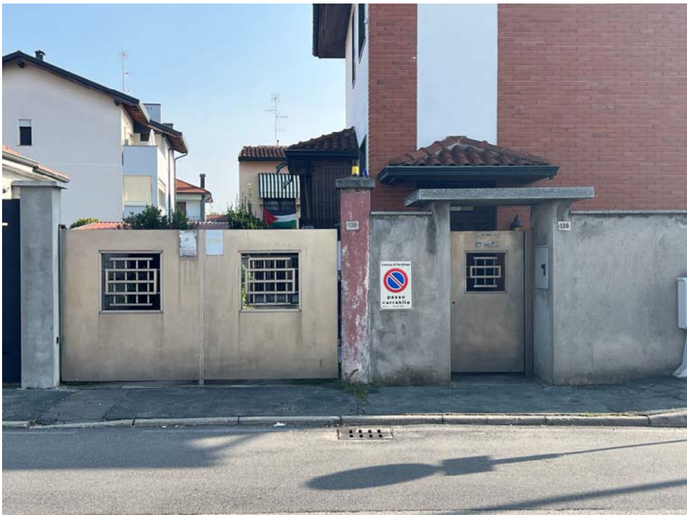
Cancello carraio e pedonale
